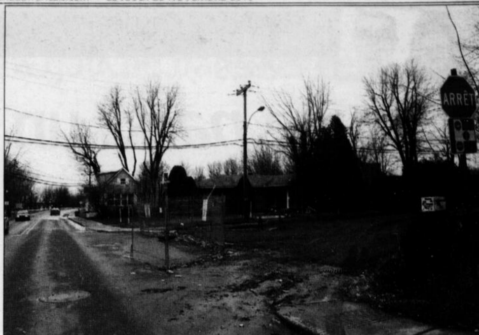
Le chantier n'accuse pas de retard, malgré le temps pluvieux de cet automne.
