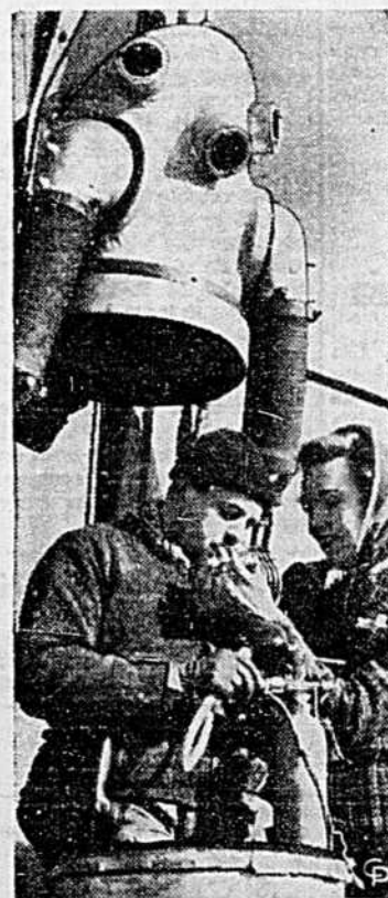
Pendant que son épouse lui allume sa cigarette, Cyril von Baumann, voyageur, conférencier et écrivain bien connu, s'apprête à expérimenter un nouveau genre de scaphandre qui permettrait de plonger dans les profondeurs de l'océan sans avoir recours au tube à oxygène. La résistance de cet habit permettrait d'atteindre une profondeur de 2,000 pieds et un mélange d'oxygène et d'hélium remplacerait avantageusement le tube d'air provenant de la surface.
