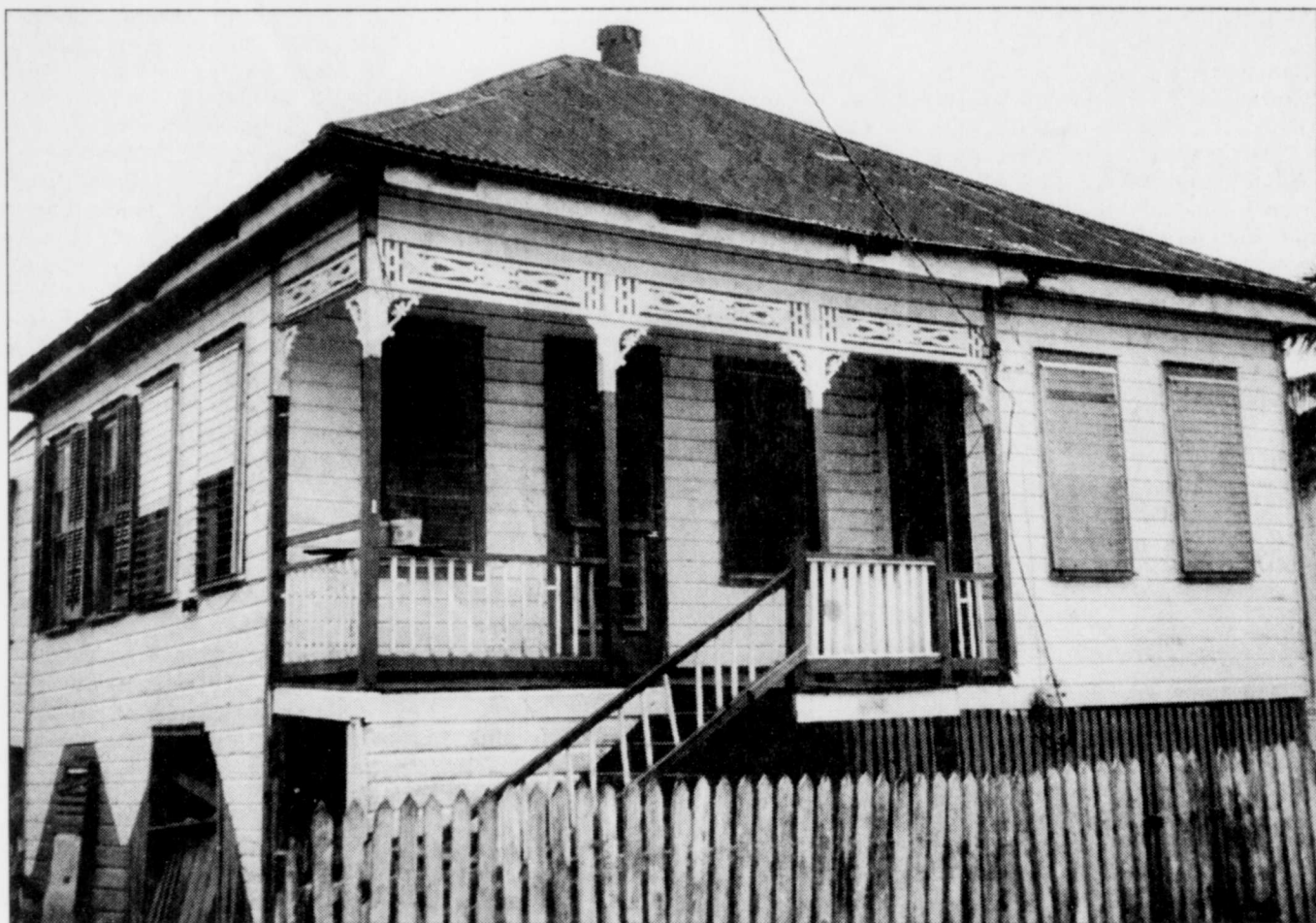
Maison typique de bois sur pilotis à Belize City.
