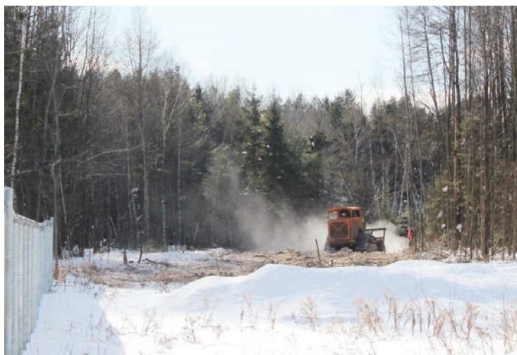
Les travaux de déboisement pour la construction d'une nouvelle rue dans le parc industriel ont commencé en janvier.
