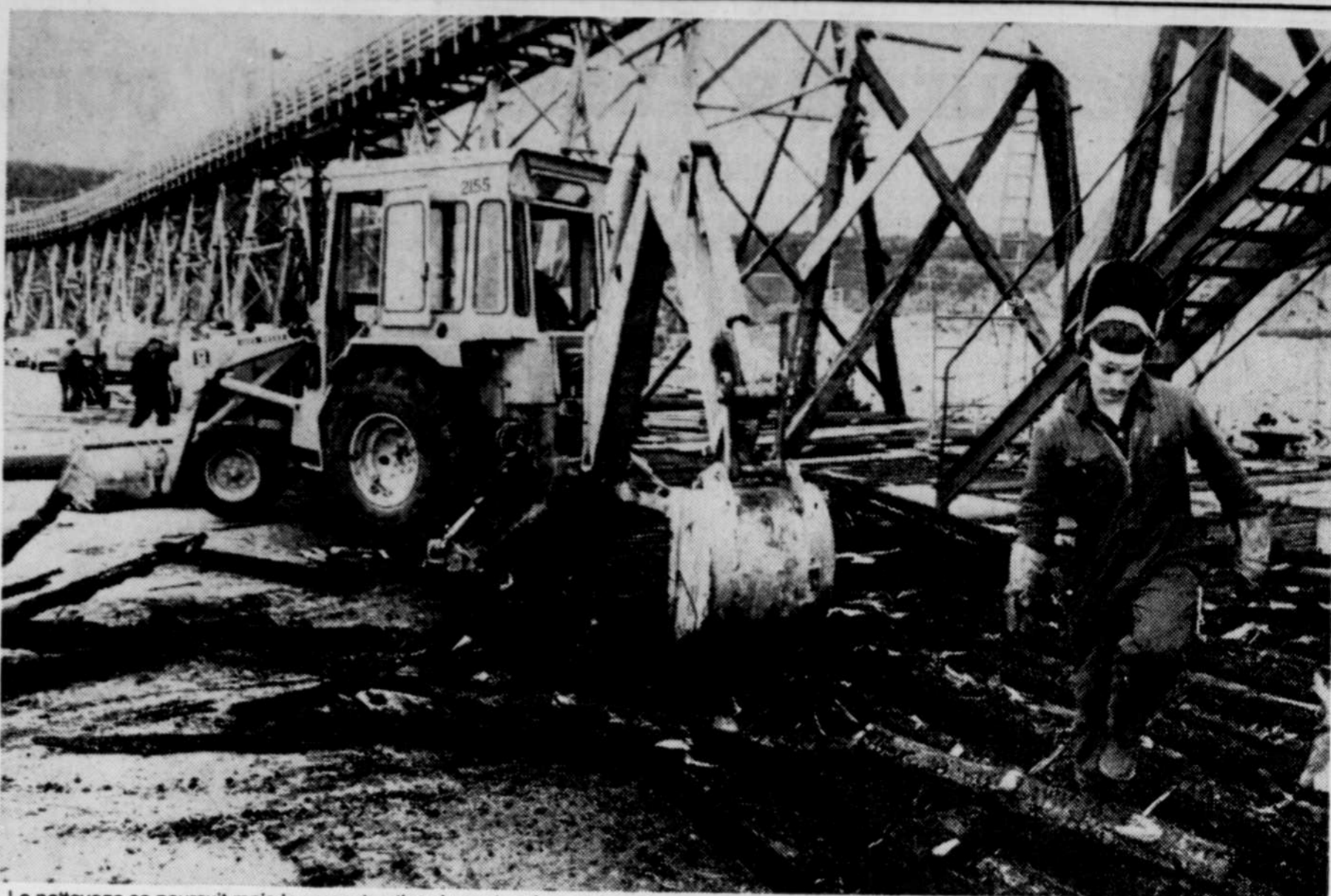
Le nettoyage se poursuit mais la reconstruction du quai se fera plus tard.
