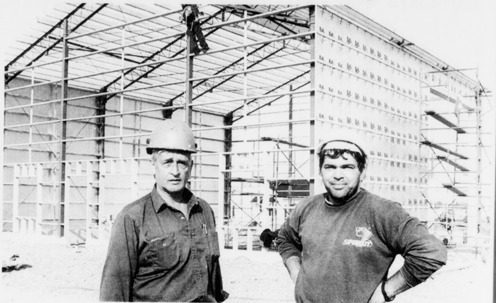
USINAGE - Présentement en construction, l'Atelier d'usinage et de soudure Desbiens inc. ouvrira ses portes fin novembre, début décembre. Sur cette vignette, les deux propriétaires Clément Fiset et Janel Rondeau.
