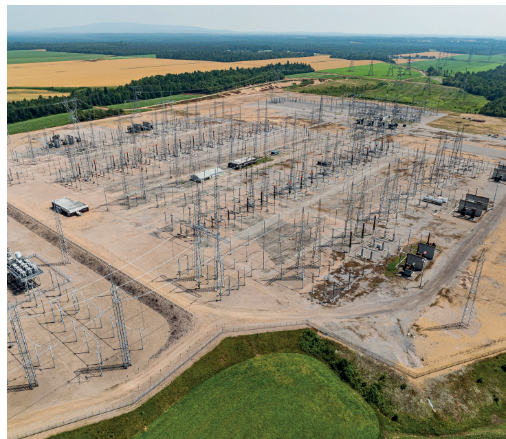
Un poste de distribution d'électricité sera construit dans le secteur délimité par des lignes jaunes sur la carte placée ci-haut. Photo - Offerte par Hydro-Québec
