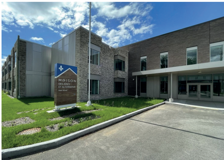
Inauguration de la Maison des aînés de Pont-Rouge. Photo - Archives
