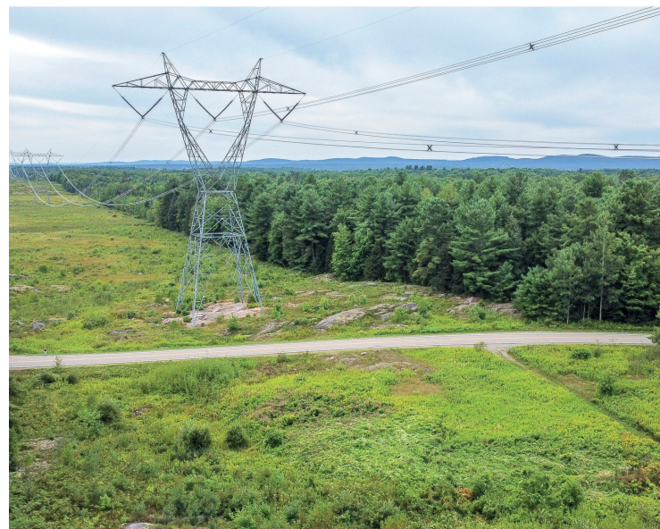
La ligne de 735 kV nécessitera un pylône à environ tous les 400 mètres. Photo - Offerte par Hydro-Québec
