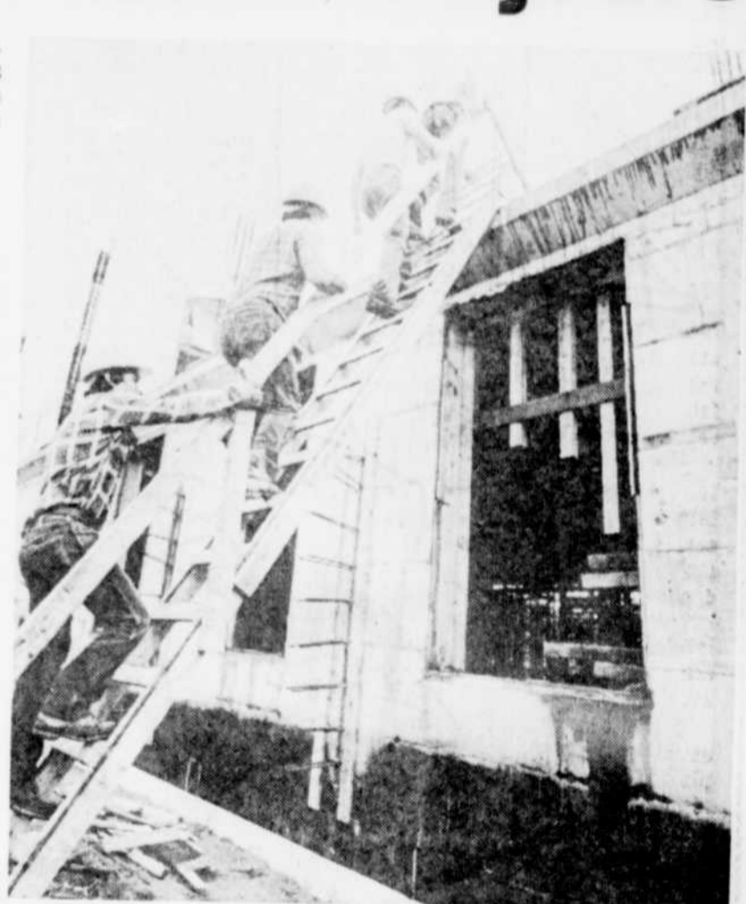
Les travaux de construction sont en cours à Sainte-Foy. D'ici la fin d'août, les 50 ouvriers sur le chantier termineront la mise en place de la charpente du bâtiment.
