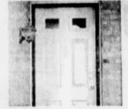
Portes d'entrée installées**
