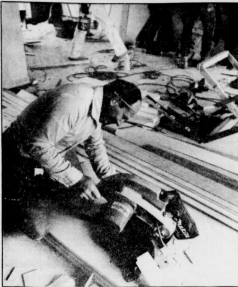
Les propriétaires ont tout intérêt à suivre la progression des travaux, vérifier la qualité des matériaux et poser des questions.
