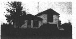
3- HENRYVILLE: rénové, accès à la rivière, à la campagne. N. Beauchemin.
