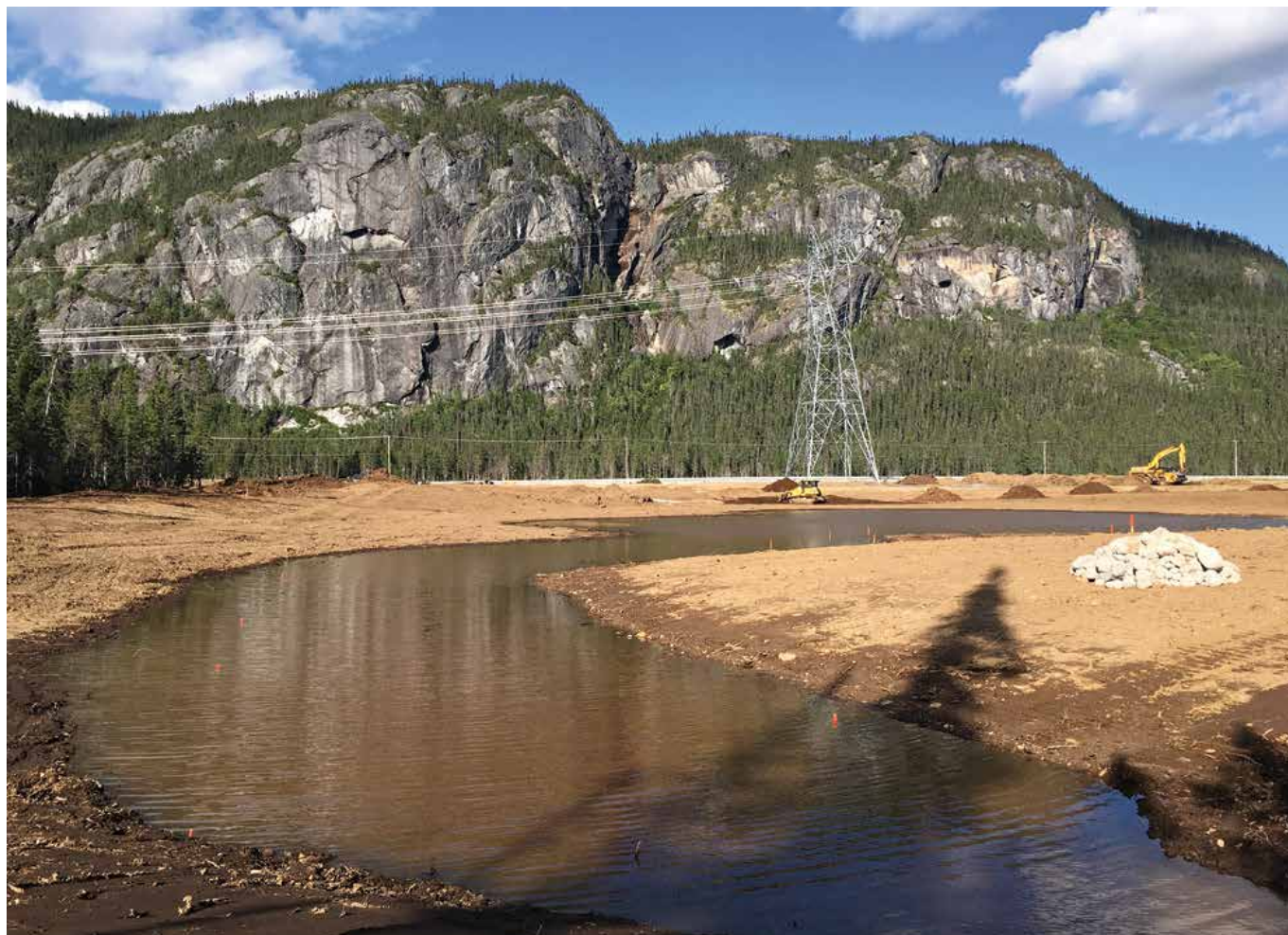
Travaux d'aménagement de l'étang du Mista en 2018
