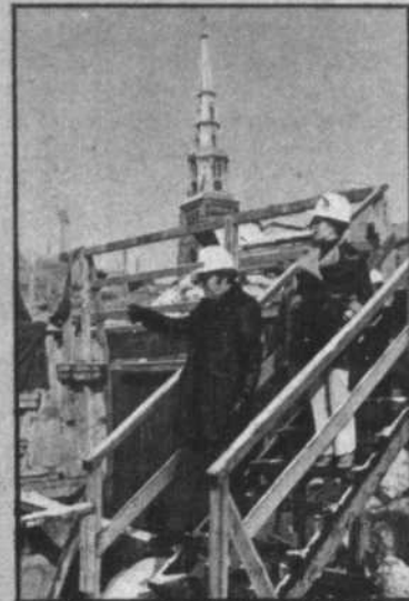
C'est sur le chantier de la Place Radio-Canada qu'ont été tournées les scènes de cet épisode de "Rue des Pignons" Pierre Boucher fait visiter à Marie-Josée Longchamps le site.
