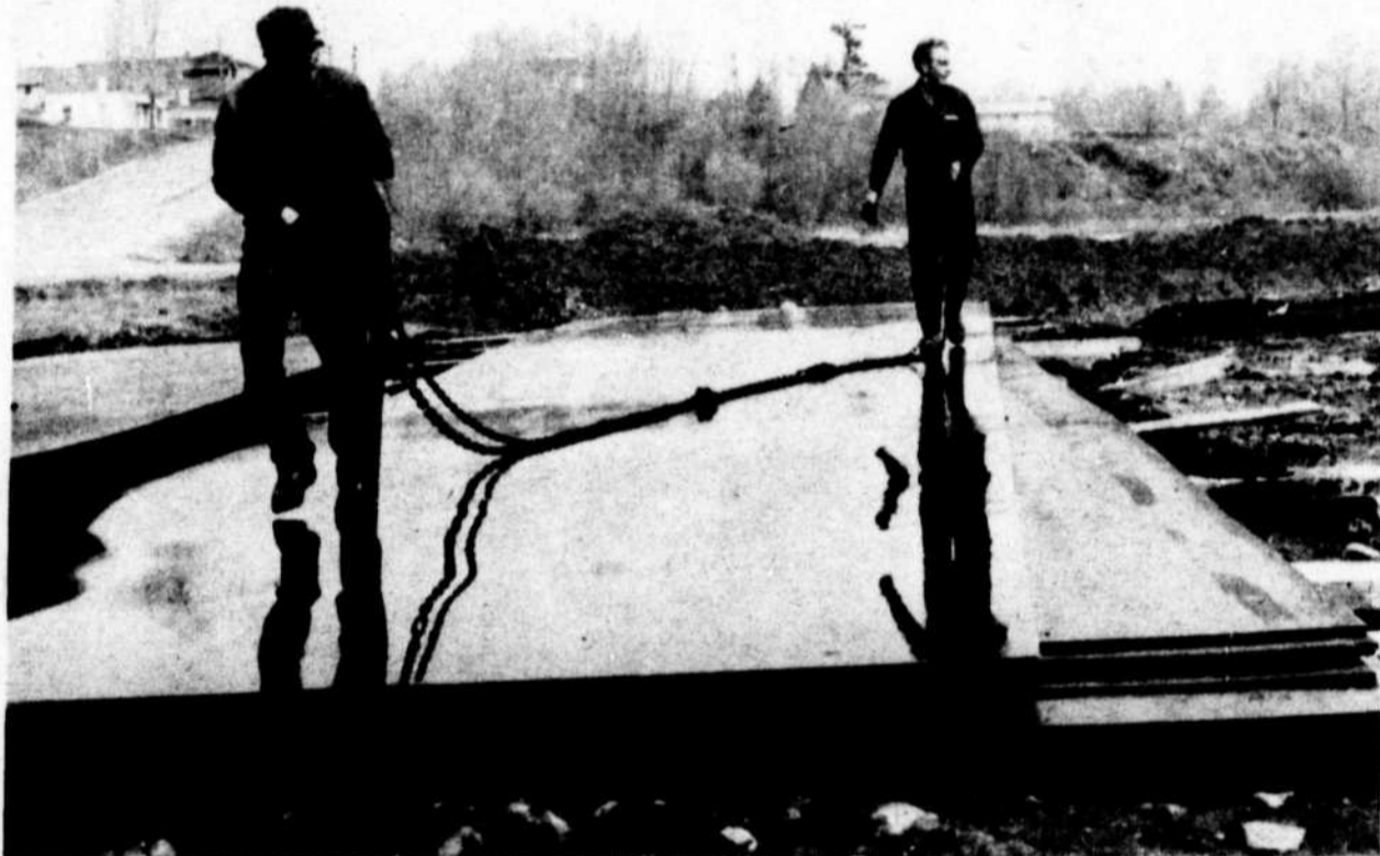
La compagnie Auto precast prenait livraison d'énormes plaques de fer destinées à servir de plancher aux formes de béton qui seront fabriquées prochainement à Buckingham. Chaque plaque d'un demi pouce d'épaisseur mesure 11 pieds par 44. Les ouvriers ont dû les huiler avant de pouvoir les glisser les unes sur les autres. Un estimé conservateur place chaque plaque à 5,500 livres. Les plaques sont arrivées à Buckingham sur un wagon plat du C.P.R. et acheminées vers l'usine Auto Precast trois ou quatre à la fois par camion remorque.
