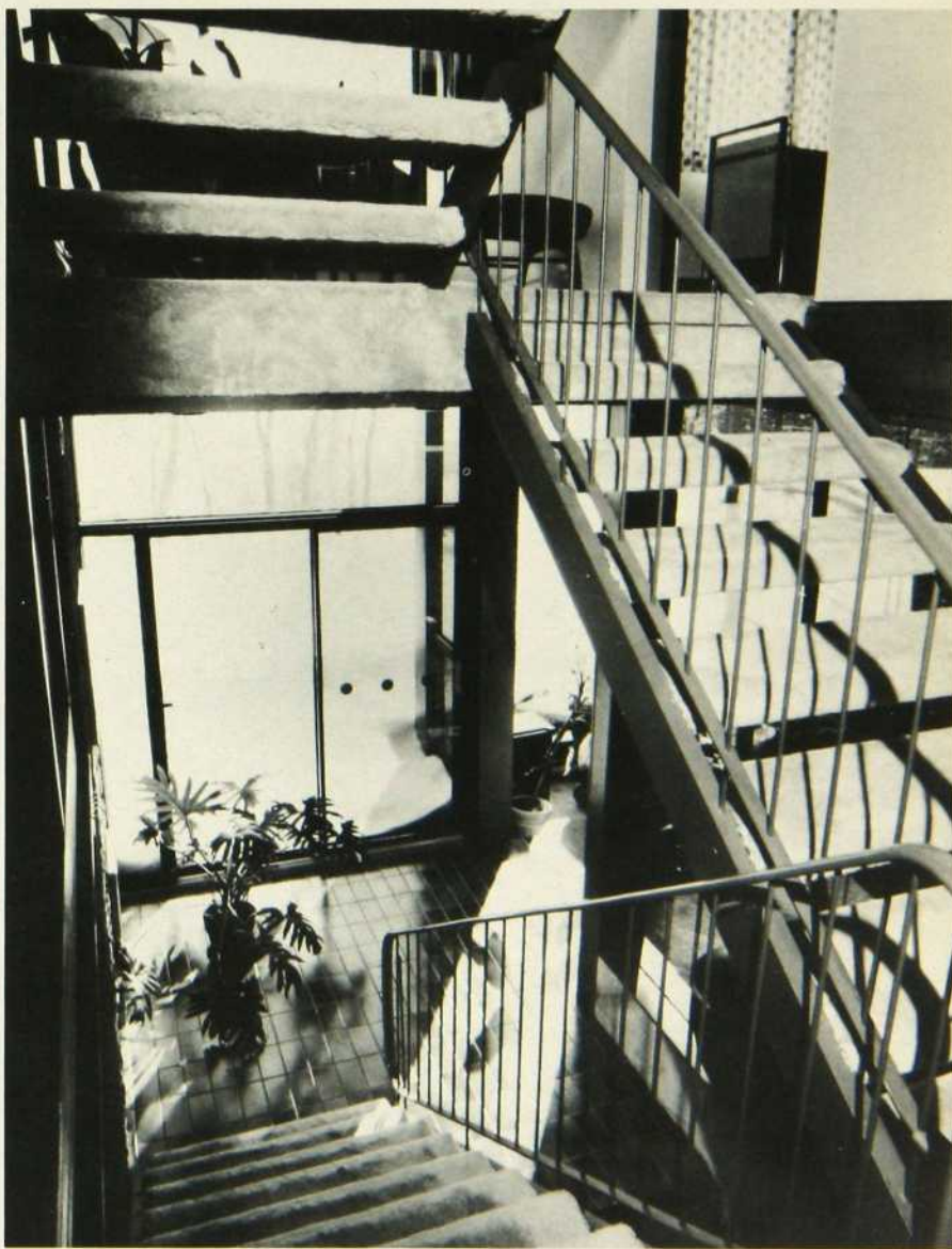
L'escalier délimite les deux parties principales de la maison et c'est par lui que l'on accède à chacune des six aires d'occupation de la maison. Une rampe plastifiée rouge et de fins barreaux métalliques caractérisent son allure de légèreté aérienne.
