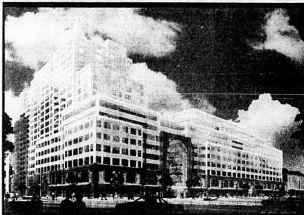
Complexe du Fort. Futur site du Collège LaSalle (janvier 1990)
