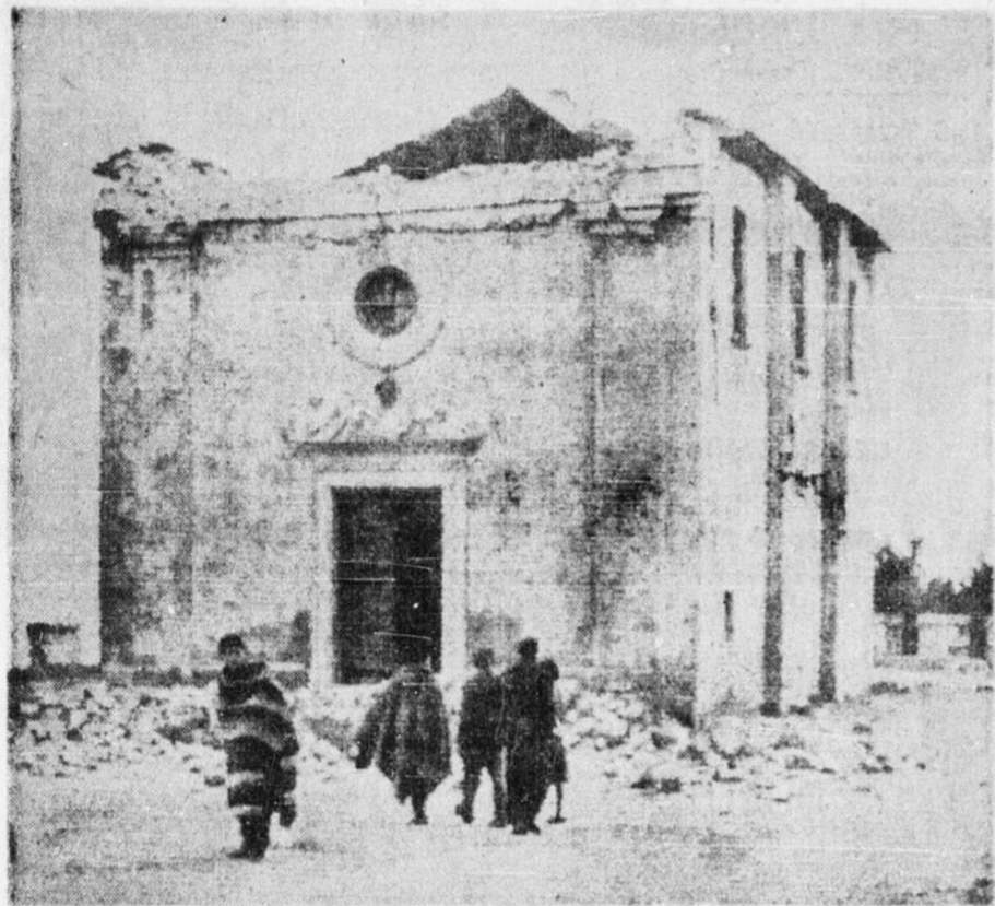
L'ÉGLISE DE ARIANO IRPINOM n'est que ruines à la suite d'un tremblement de terre qui a ravagé la région, hier, dans cette partie du
