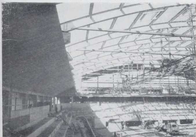
Détail des arches d'acier formant la structure du toit.
