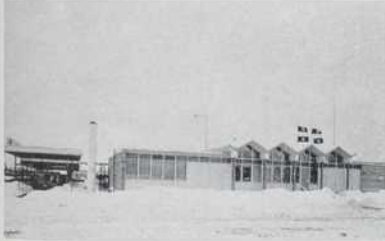
Vue arrière du poste de Laval-des-Rapides.
