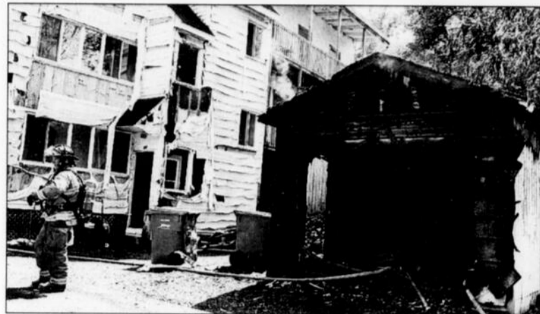
Le petit garage situé à l'arrière du 310 rue Bégin a été complètement ravagé par les flammes, hier après-midi.
