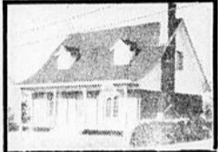
671 rue des Buissons
