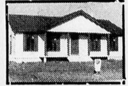
Rue des Hêtres S.-Coeur
