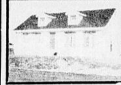
683 rue Des Buissons
