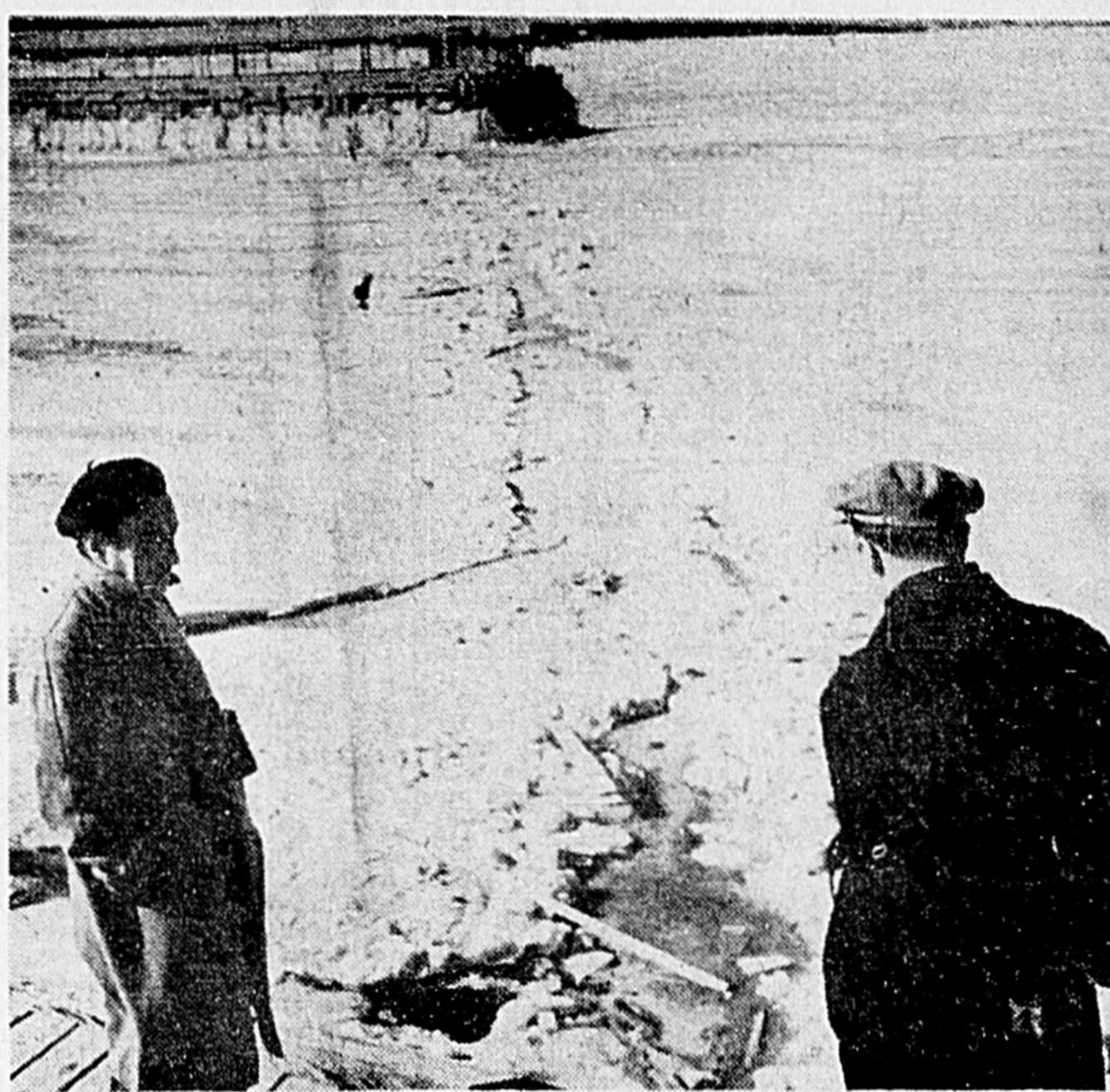
M. Gaston Gauthier, ing. p., à gauche, et M. Ulric Bouchard, à droite, regarde le sillon creusé dans la glace, à Port-Alfred, par un tuyau perforé déposé à 40 pieds sous l'eau dans lequel on a fait passer de l'air comprimé. Une mince couche de glace couvre la surface, la pompe n'ayant pas fonctionné durant la nuit.
