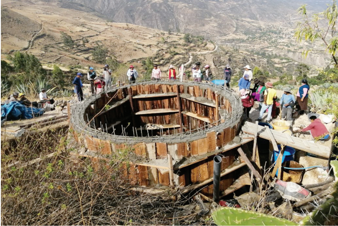
Construction du réservoir sur la colline
