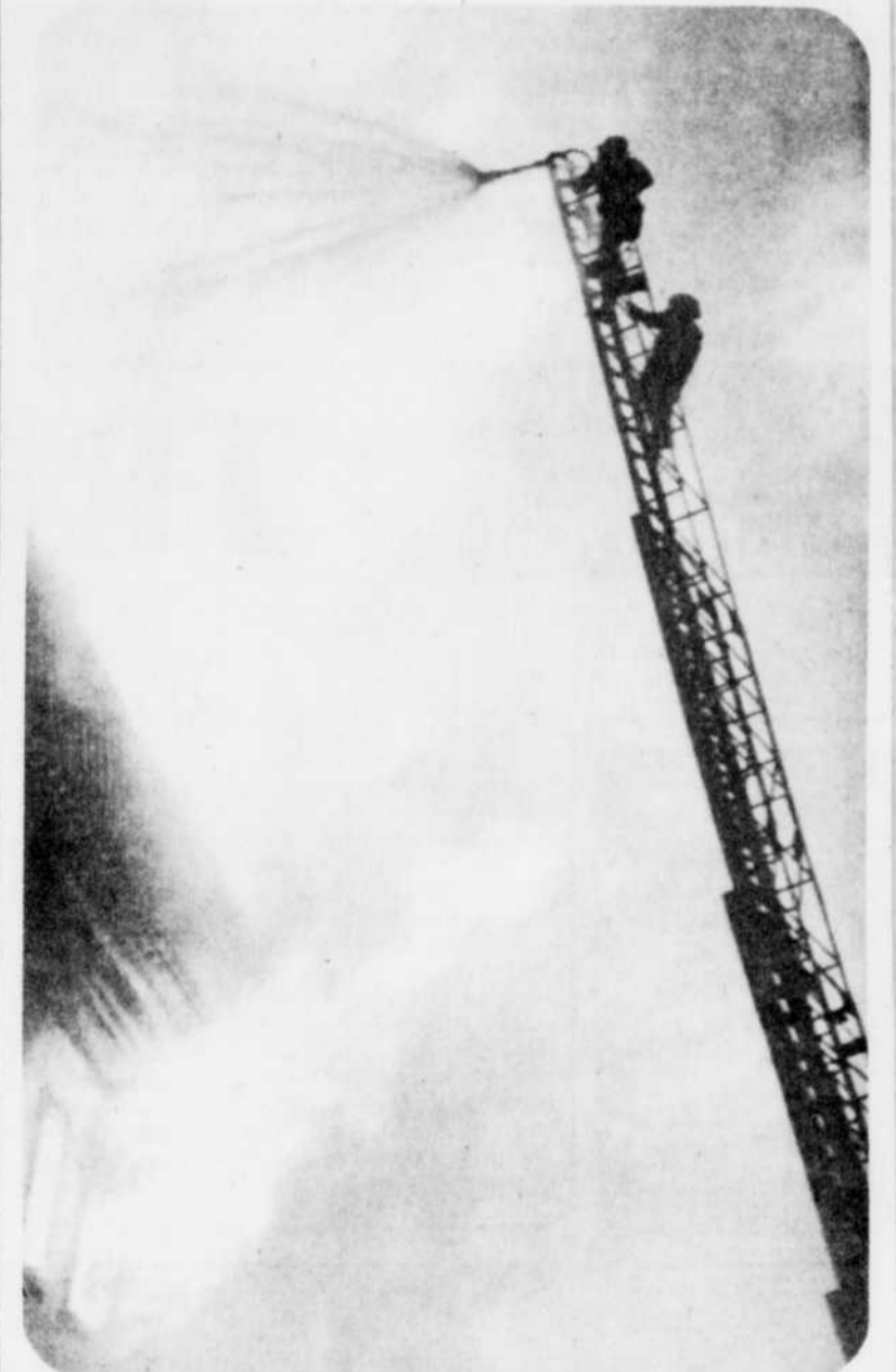
Les flammes s'échappent du toit et des fenêtres du Club Rideau d'Ottawa. Le bâtiment situé en face du Parlement a été complètement détruit par un incendie hier soir.
