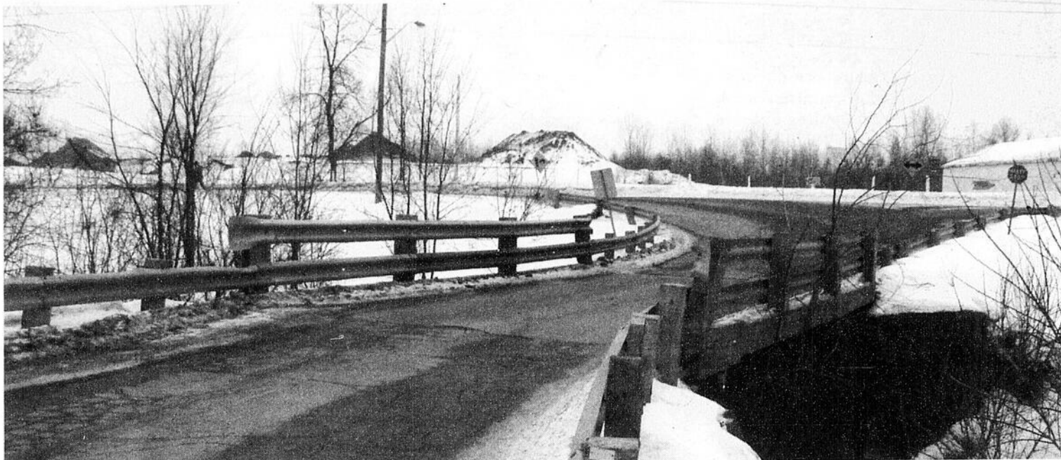
Le pont situé sur le chemin Saint-Pierre, au coin de la Cabane Ronde, fait partie des 4281 ponts de la province récupérés par le ministère des Transport du Québec. (Photo: Gilles Bordonado)
