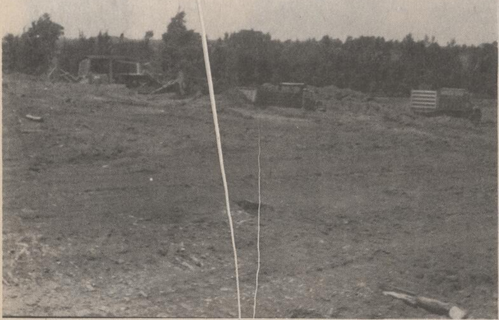
Les travaux de déblaiement se poursuivent actuellement de part et d'autre du nouveau pont sur la rivière
