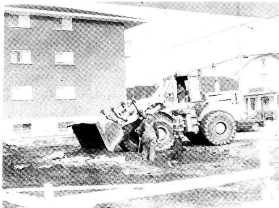
L'ancien lave-auto de la rue de la Cathédrale, n'est plus. On le remplace par un centre d'alignement.
