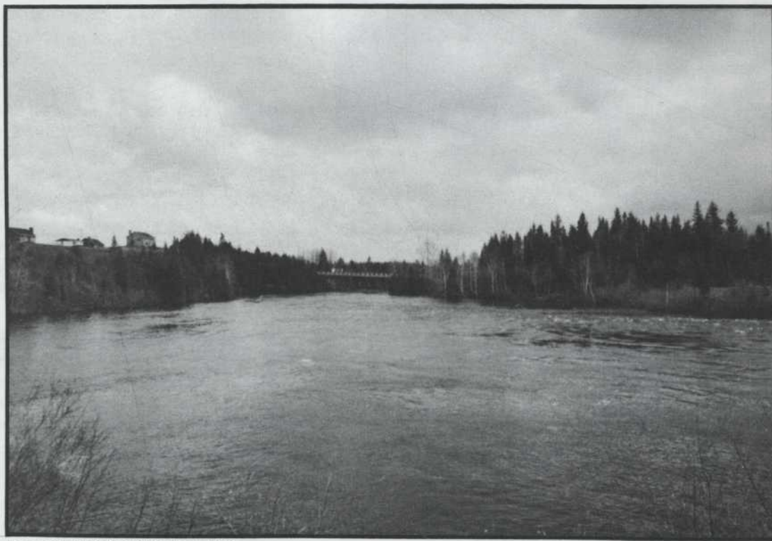
Le pont de la rivière Shipshaw, 1979.
