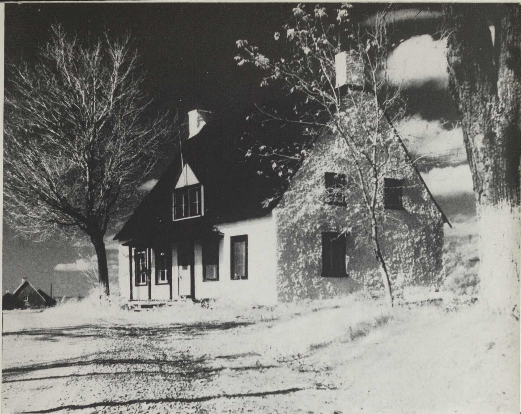
The Morisset farm-house, at Cap-Santé, has withstood the ravages of time since 1696. La maison de la ferme Morisset, au Cap-Santé, résiste aux injures du temps depuis l'année 1696.
