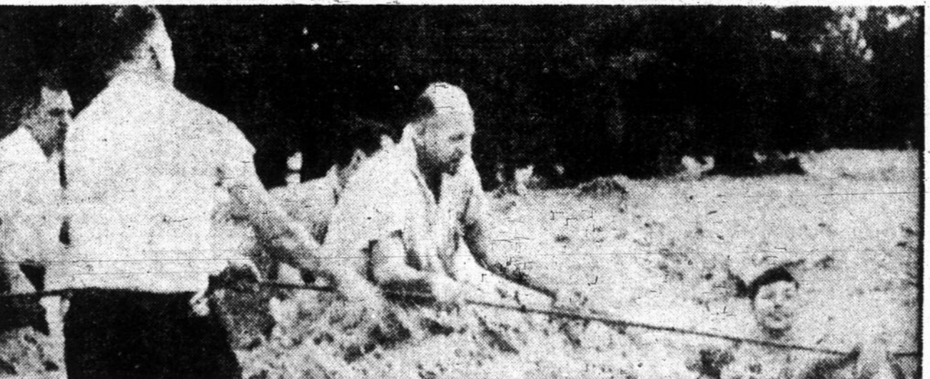
SAUVETAGE SOUS LE SIGNE DE LA GAIETE — Un sauvetage sous le signe de la gaieté, à San Antonio, Texas. Jackie Benise était prisonnière du torrent déchaîné de l'inondation, à l'angle de la rue Donaldson et Seeling Boulevard. Elle a perdu son auto, mais du moins elle a été sauvée par des voisins obligeants qui se sont portés à son secours. (Fac-similé United Press — "Montréal-Matin")
