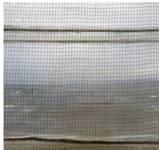
Figure 1. Filet installé dans l'ouverture d'une ventilation naturelle. Photo prise par Sébastien Fournel.
