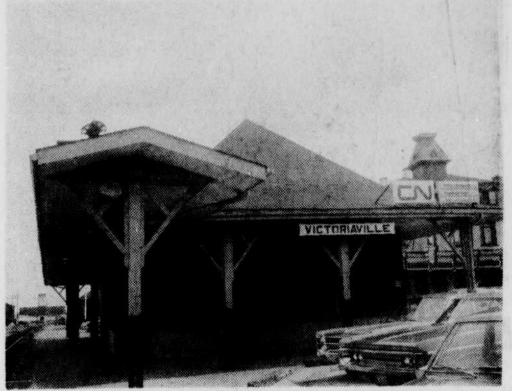
1972 verra disparaître un peu de la petite histoire de la ville de Victoriaville, lorsqu'en décembre, la vieille gare du CN, au centre-ville tombera sous le pic des démolisseurs. (Photo LeRo)
