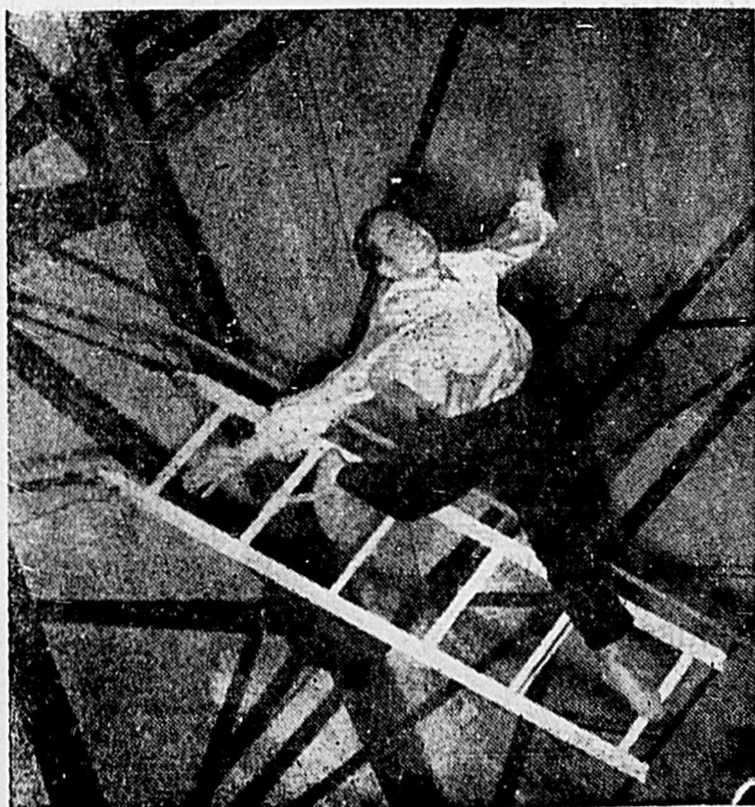
Echelle volante au toit de l'aréna.
