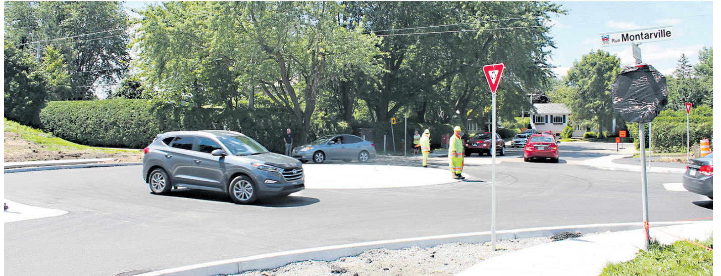
Les travaux d'aménagement du minicarrefour giratoire sont terminés. (Photo : Frank Jr Rodi)
