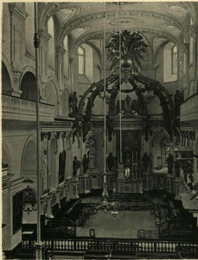
Interior of the Basilica R. C. Intérieur de la Basilique C. R.
