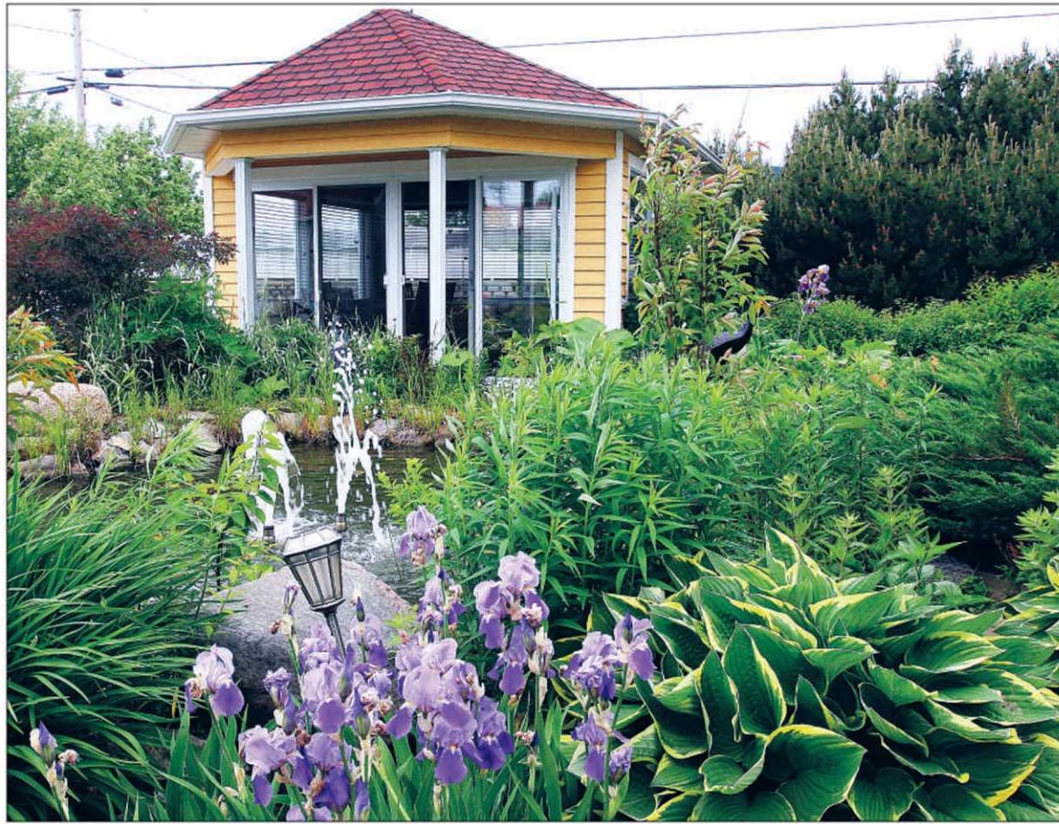
Le pavillon-chalet que le couple Corriveau-Bilodeau a bâti dans sa cour mesure 12 X 14 pieds. Il est entièrement isolé et recouvert de clins de pin teints en usine. L'ensemble du projet a coûté 15 000 $ en excluant la main-d'œuvre.
