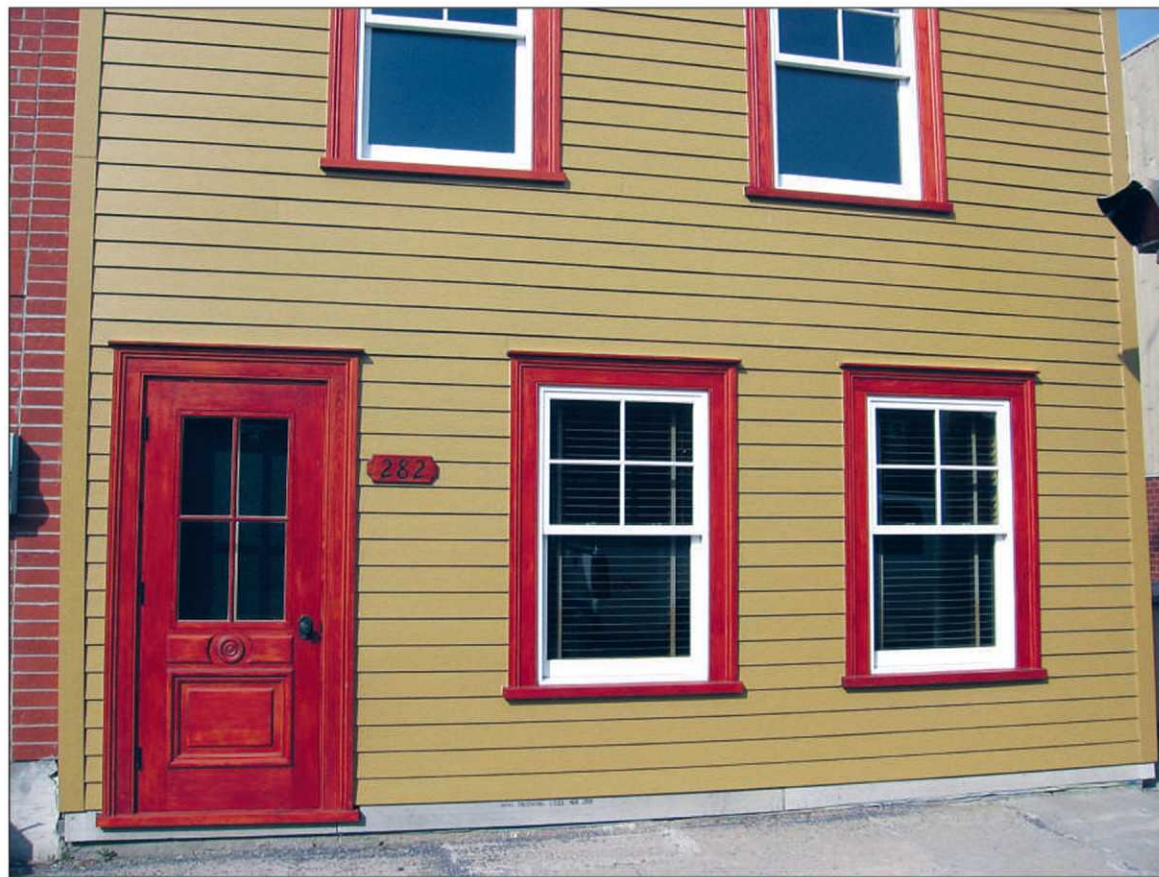
La cote énergétique d'une porte de bois massif, qui doit avoir au moins deux pouces et quart d'épaisseur, est moins élevée que celle d'une porte en acier, indique Pascal Jalbert, propriétaire de Menuiserie Delisle à Québec, une entreprise qui fabrique des portes en bois sur mesure. — PHOTO MENUISERIE DELISLE
