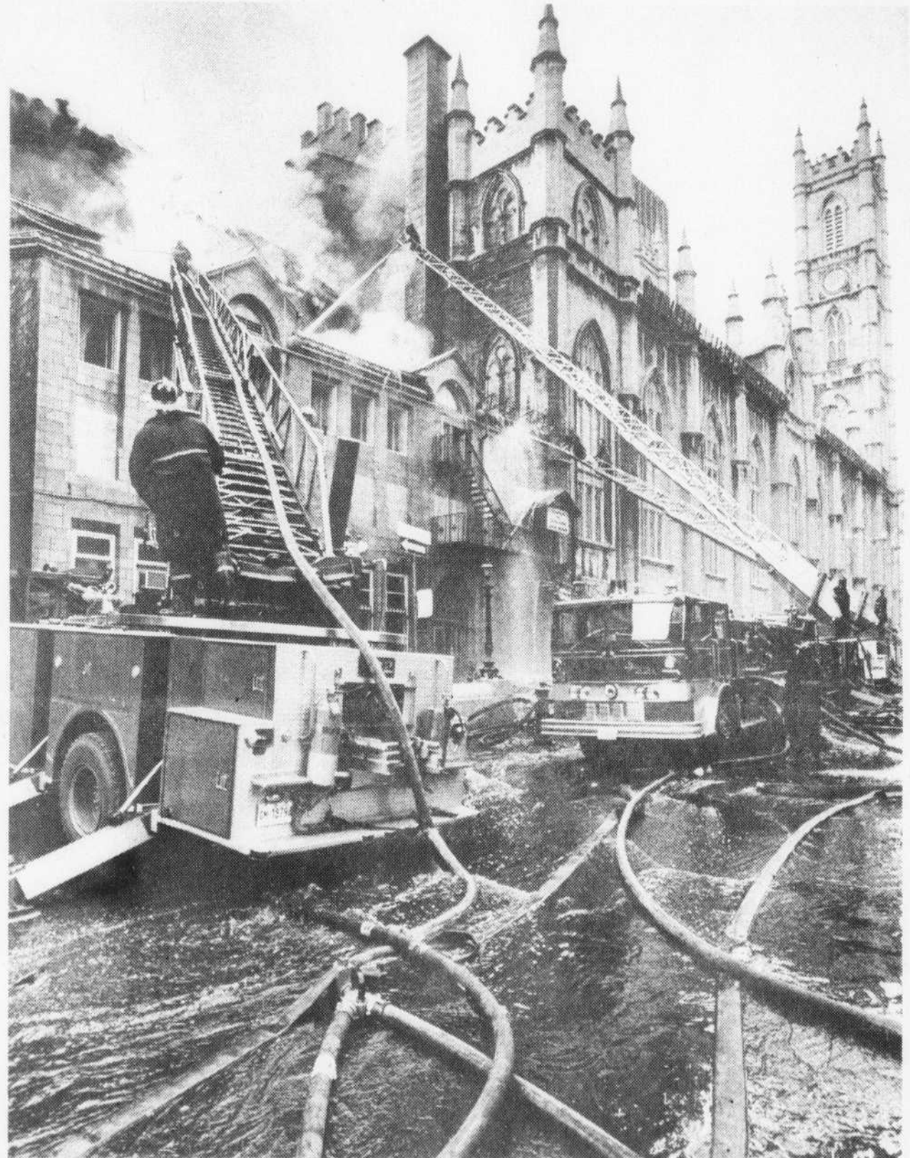
Les pompiers de Montréal ont déployé une vingtaine d'appareils tout autour de l'église pour circonscire l'incendie à la partie arrière. (Photo Jacques Grenier)
