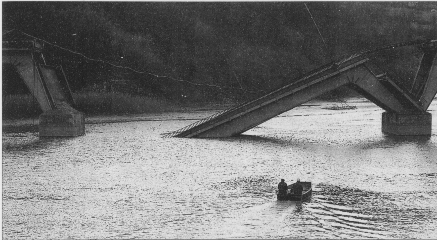
Les forces de l'OTAN ont détruit hier un pont sur la rivière Lim près de Bistrica. Les bombardements d'hier en Yougoslavie ont atteint une intensité sans précédent depuis le début des frappes aériennes, il y a trois semaines.
