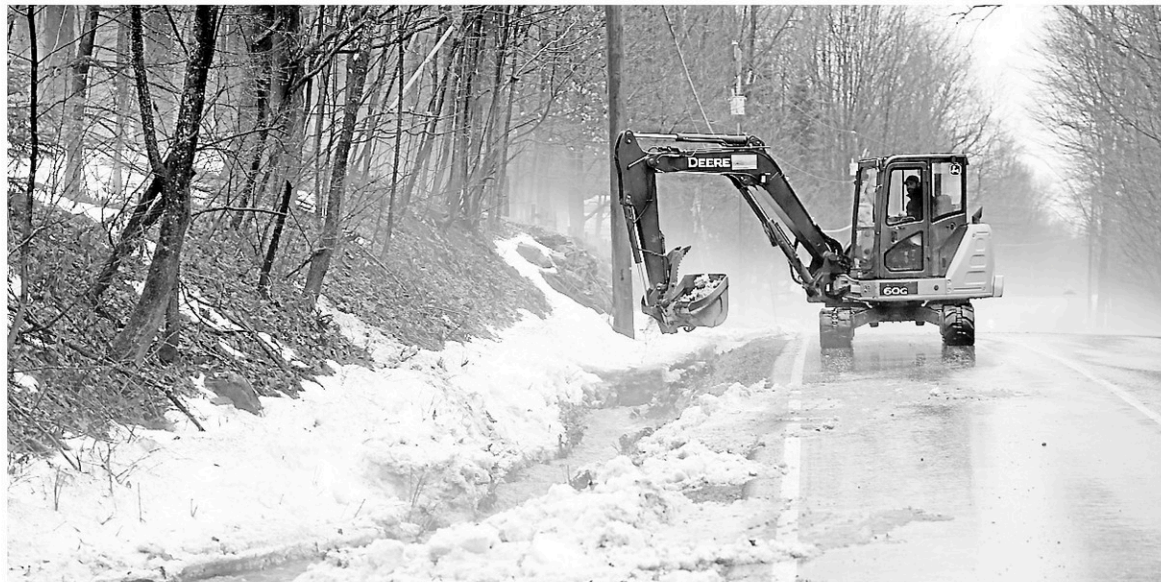
Dans la rue Saxby Sud, à Shefford, on a tenté de dégager le fossé à l'aide d'une pelle mécanique. — PHOTOS CATHERINE TRUDEAU
