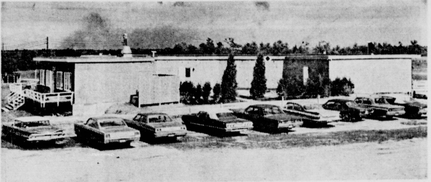
Le club de golf St-François a son nouveau chalet. Lorsque la construction en sera complétée, cette bâtisse aura une forme octogonale.
