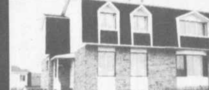
TERREBONNE (ST-LOUIS): $89,000. Beau cottage jumelé, 3 chambres même niveau. Piscine. Près de tout.
