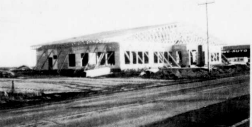
La construction de l'un des plus importants complexes hôteliers de la Mauricie, évalué à $1,5 million, incluant la chaîne de restauration Au Coq Rôti, d'un bar-salon, d'une somptueuse salle à dîner et d'une salle de réception d'une capacité de 800 personnes, de deux salles de conférence et d'une garderie, est présentement en cours sur la route 138 dans la municipalité de Saint-Antoine-de-la-rivière-du-Loup.
