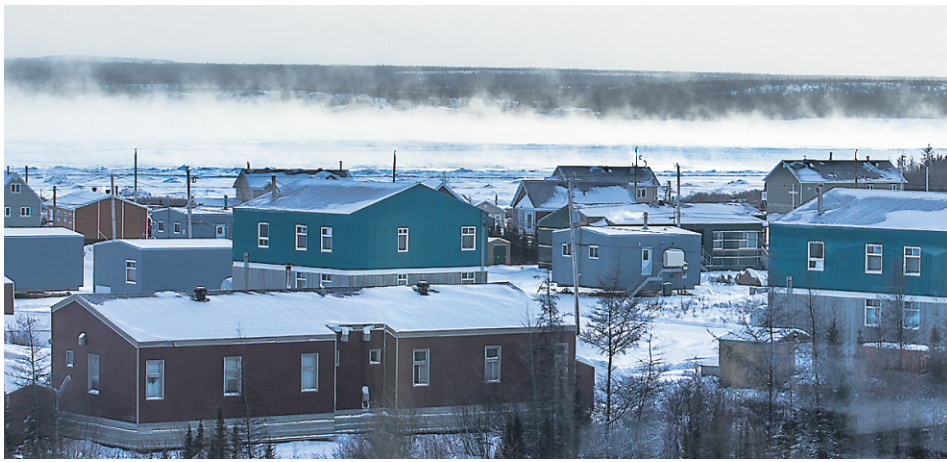
À Kuujuaq, les maisons ont des pilotis plutôt que des fondations afin de contourner les effets négatifs du pergélisol, cette couche de sol perpétuellement gelée.
