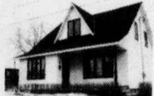
LE GARDEUR: Splendide cottage entièrement rénové, cuisine moderne, fenêtres françaises, impeccable. MICHEL ETHIER.
