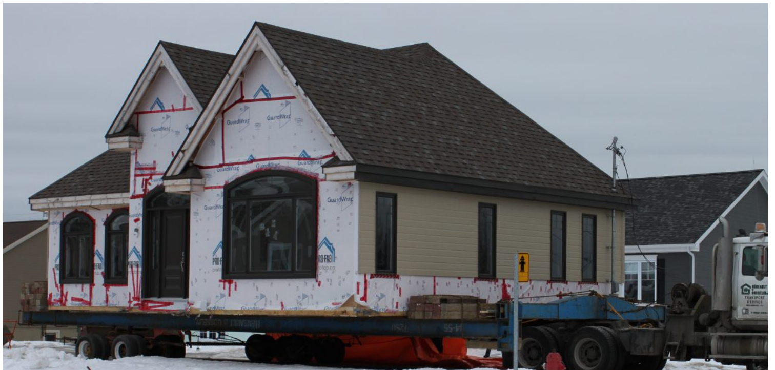
Dans ce dossier d'affaissement des sols dans le quartier du Haut-Sainte-Famille, la Ville de Sept-Îles avait dû déplacer 28 résidences à ses frais. Le problème était lié à la capacité portante des sols provoquant l'affaissement des immeubles.
