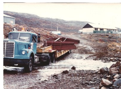
Chantiers de l'entreprise d'Arthur, en particulier ici, la phase de l'édification de l'entrepôt d'Arthur par l'équipe de J. Bastien
