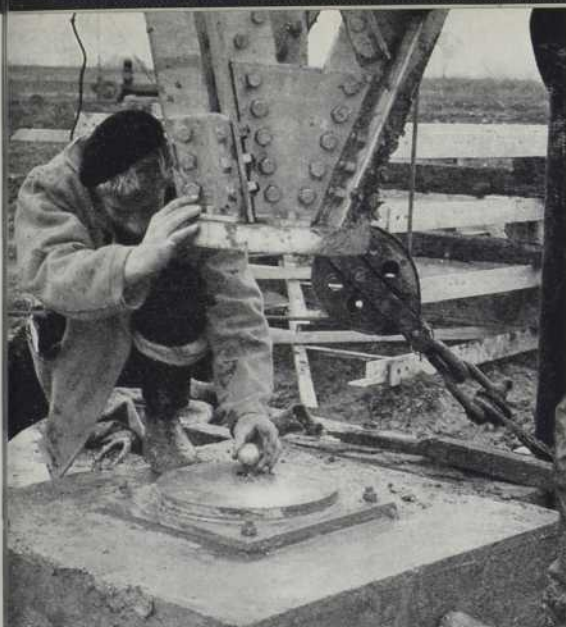
Un ouvrier place la bille d'acier qui recevra la base de la colonne géante pesant vingt-six tonnes
