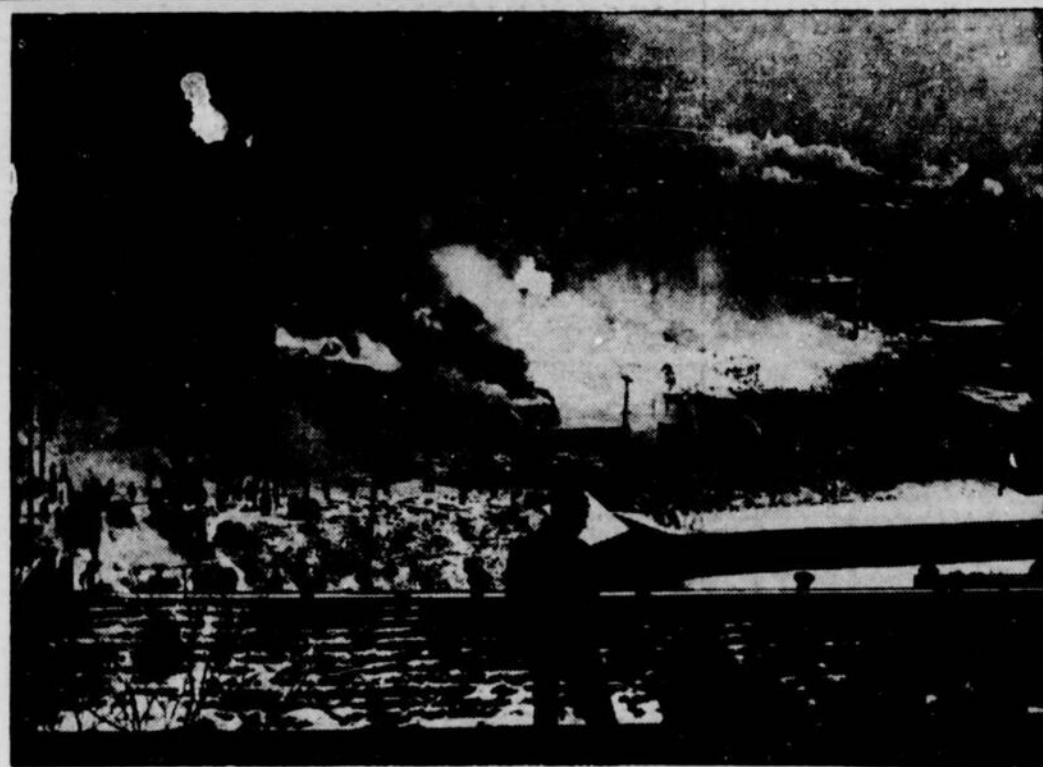
Un incendie, qui a éclaté à l'entrepôt de la New-York Live Poultry Company, à Hoboken, New-Jersey, a pris rapidement des proportions alarmantes et s'est propagé à une manufacture et à plusieurs maisons avoisinantes. Toute la brigade de feu de Hoboken fut dépêchée sur les lieux, assistée par la majeure partie des pompiers de Jersey City. Les dommages s'élèvent à plusieurs centaines de mille dollars. Cette photo a été prise du toit d'un édifice, près des lieux du sinistre.
