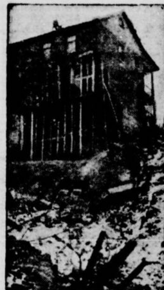
La moitié de cette maison située avenue Eastmount, à Toronto, a été démolie par un glissement de terrain, laissant l'autre moitié de la demeure dans une position précaire. Personne n'était dans l'immeuble au moment de cet accident imprévu.
