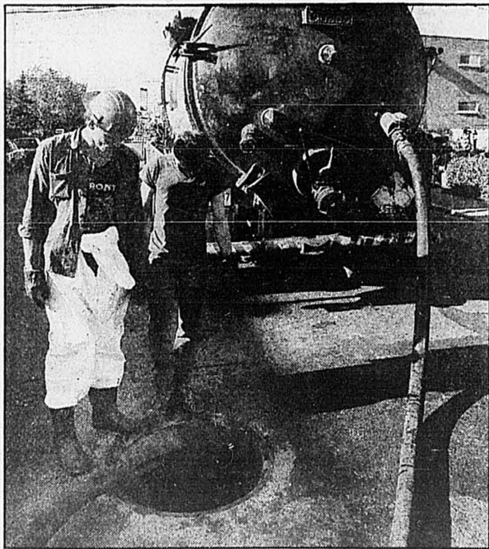
Pacifique Laroche et Pierre Daigle de la compagnie R. Berthiaume Inc. s'affairaient hier à pomper l'huile du réseau d'égout de la ville. PHOTO LUC SIMON PERRAULT, La Presse
