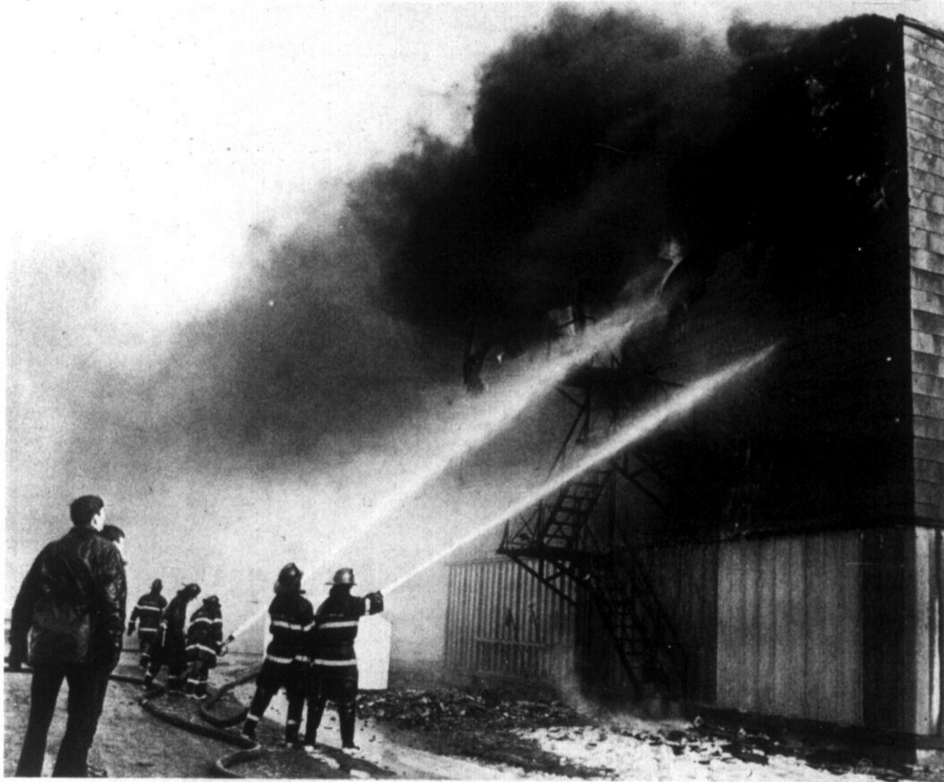
L'édifice no 145 est en forme de U. Les sapeurs ont d'abord dû combattre les flammes par l'arrière.
