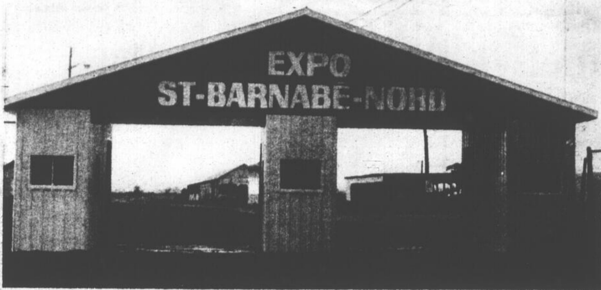
"L'accueillante" entrée principale donnant sur le terrain de l'exposition agricole et commerciale de Saint-Barnabé-Nord. Il s'agit d'une construction qui fêtera son premier anniversaire, lors de l'expo de cet été, qui a lieu du 7 au 11 juillet.
