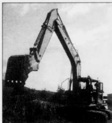
L'enrochement protège le ruisseau Taché.
